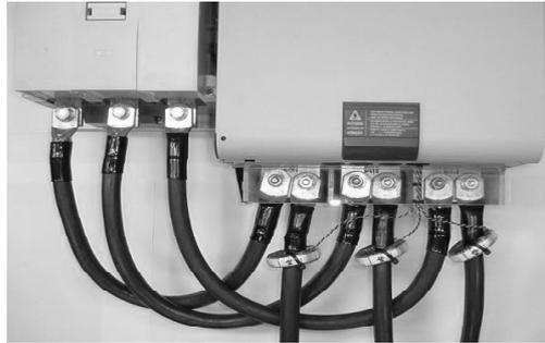
**Figura 9.15** - TCs para adquisición de corriente externa
